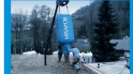
4. Sobald das MISAPOR Schaumglas vollständig auf der Fläche verteilt ist, sollte das Niveau nochmals überprüft werden. Wichtig ist wiederum, die Verdichtung zu berücksichtigen und 30% der effektiven Höhe dazuzurechnen. Die Feinjustierung der Schicht kann mit Schaufeln oder grossen Rechen erfolgen. Werden Baumaschinen für die Planierung verwendet, ist Sorge zu tragen, dass kein unerwünschter Abrieb zu einem Mehrverbrauch führt.
